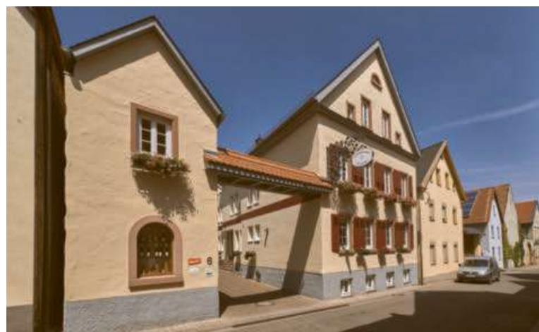
Ein Anwesen, zwei Zugänge: Das Gästehaus Schmitt ist über die Untergasse 6 zu erreichen.
